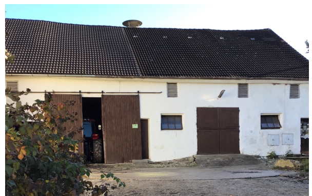
Landwirtschaftlich genutzte Gebäude im Nordwesten des Planungsgebiets
