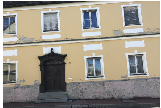
Altes Gebäude auf Flurstück Nr. 58 in Münchner Straße
