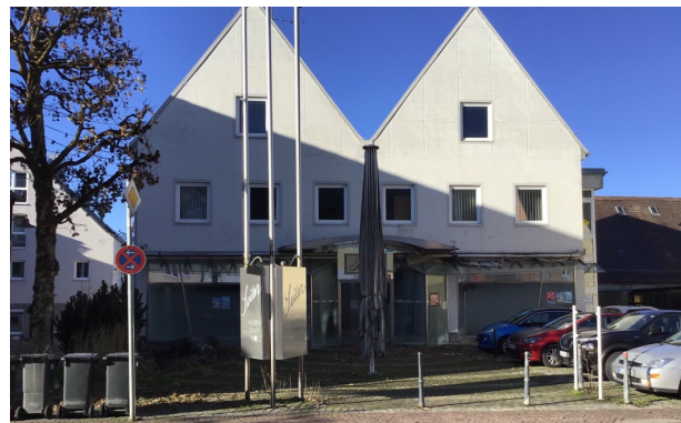
Leerstehendes Gebäude auf Grundstück Fl. Nr. 216/2 und 217, für das eine Bauvoranfrage besteht
