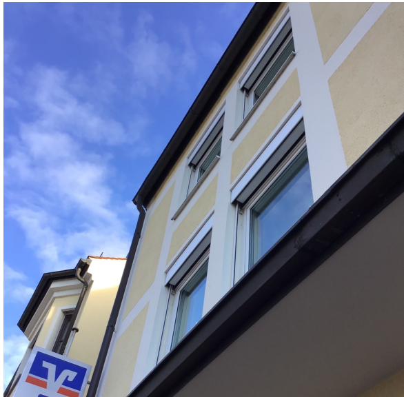
Rolladenkästen am Gebäude der VR-Bank in der Augsburger Straße
