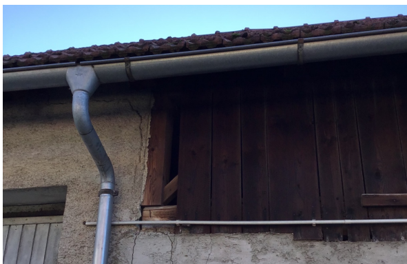
Dachboden einer Scheune
