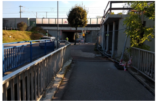
Unterführung unter Bahnlinie, südlich, außerhalb des Planungsgebiets
