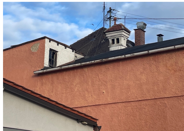
Dachbereiche mit Einflugmöglichkeiten für Vögel und Fledermäuse
