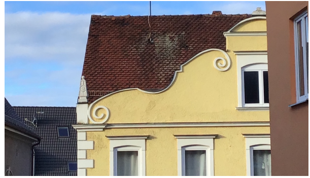
Altes Ziegeldach von Gebäude an Augsburg- Straße
